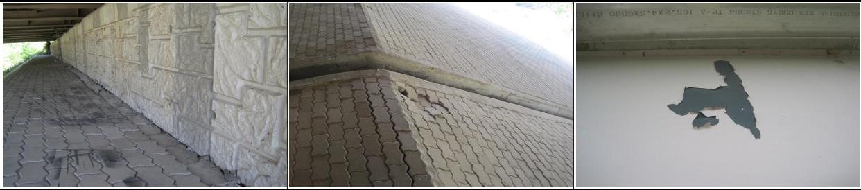
① 교대 A1 법면 보호블럭 침하-주기적인 점검을 통한 손상진전여부 확인
